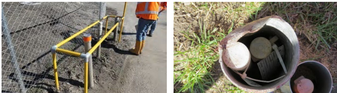
Figuur 5.1 Beschermkokers voorzien van stalen anti-maai/aanrijd constructie met hoge buis die boven de toekomstige vegetatie uit zal steken.
